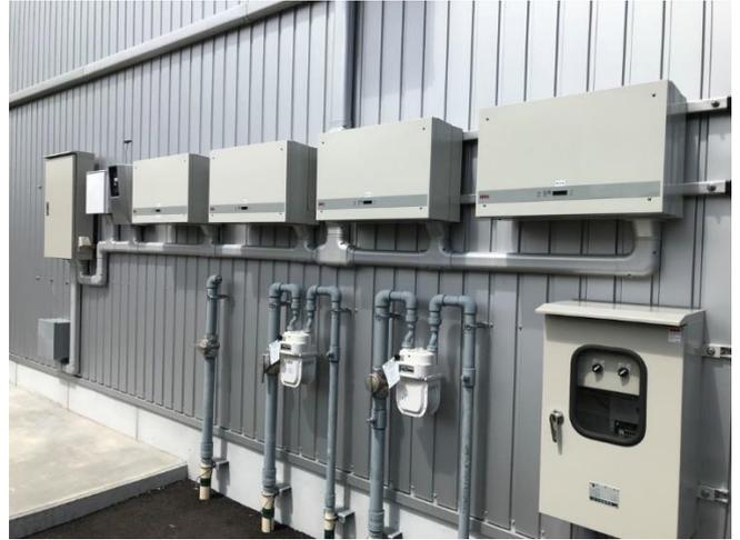
パワーコンディショナ、遠隔監視・計測システム
