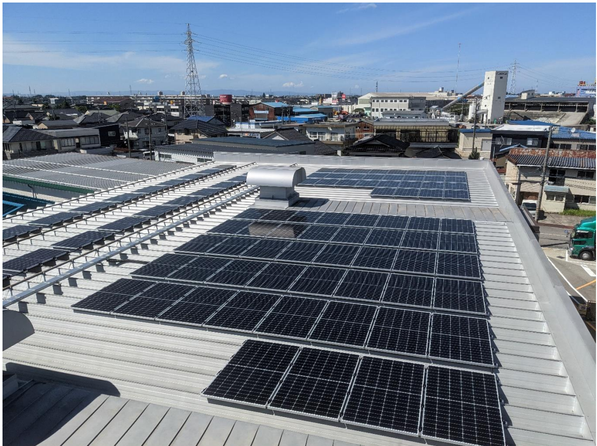
1号棟1号倉庫屋根
